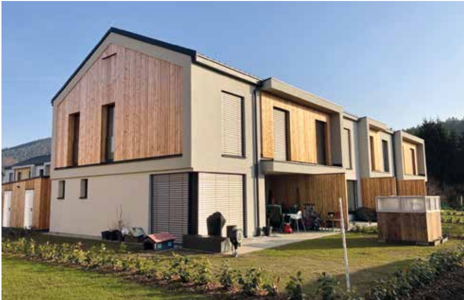
Die Ziegelwände im Erdgeschoss werden mit gedämmten Holzriegelwänden ergänzt
