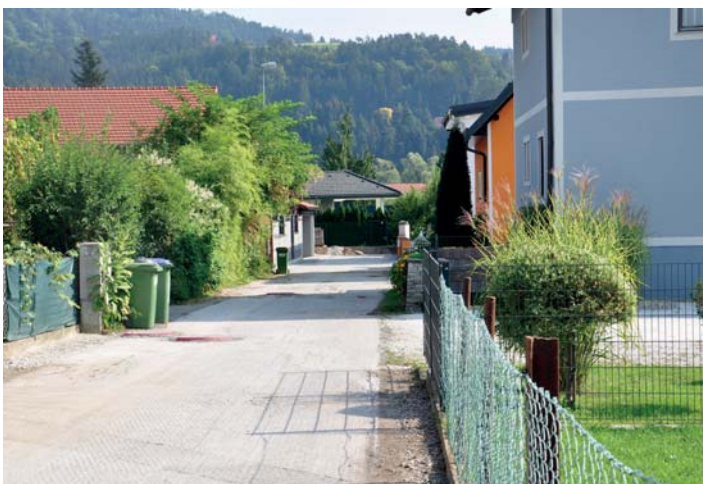
Arbeiten im Siedlerweg.
