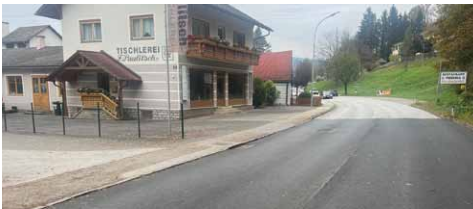
Schadhafte Stellen und beschädigte Kanaldeckel wurden repariert
