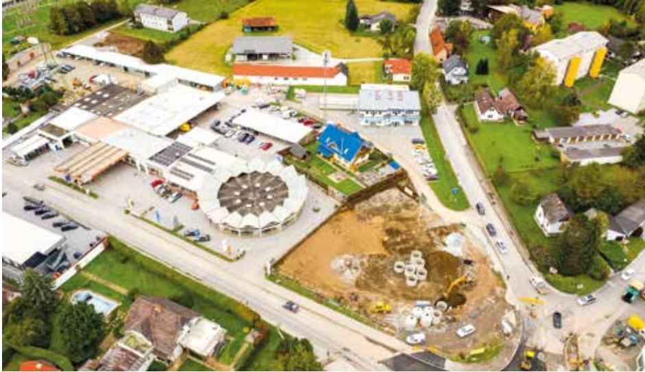
Luftaufnahme der Umbauarbeiten am beeindruckenden Fripertinger Firmenareal
